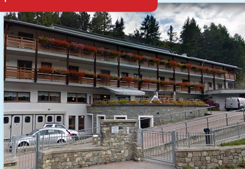
Installatore: Galli Ezio S.p.A, Lecco
