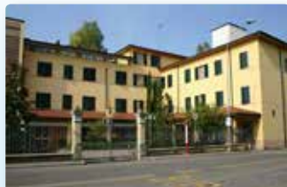
Installatore: Uniontel srl, Parma
