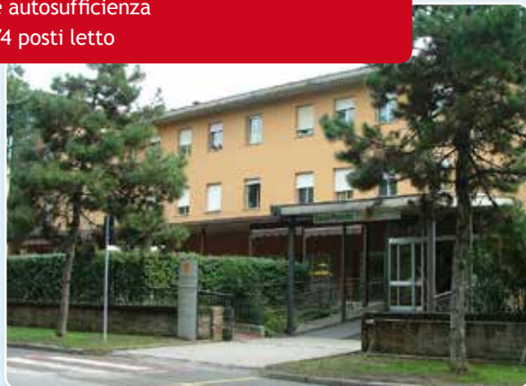
Installatore: Tecno-Alarm srl, Faenza
