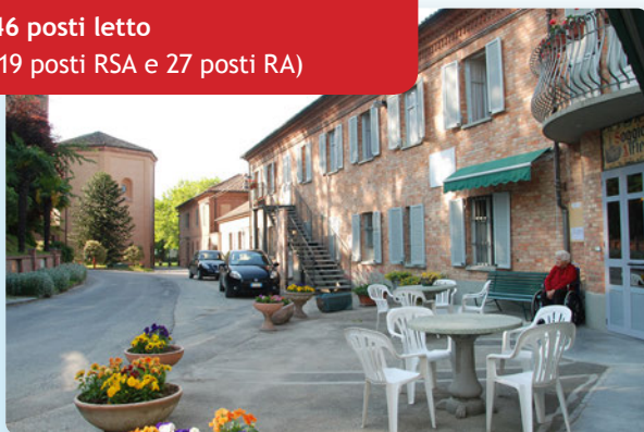
Installatore: Evotec S.n.c., Govone (CN)
